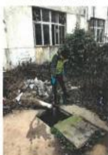
生活废水总排口
